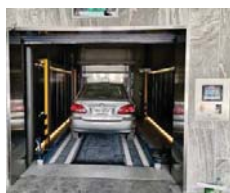
รูปที่ 5 แสดงการจอดรถบนพาเลตข้างในลิฟต์
